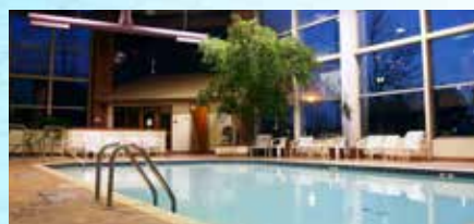
CALEFACTADO DE PISCINA
